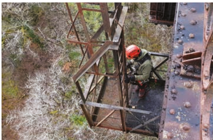
Vérification du tablier depuis la passerelle originelle.
