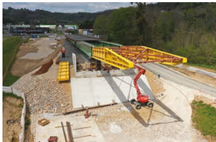
Tablier du viaduc avant lançage.
