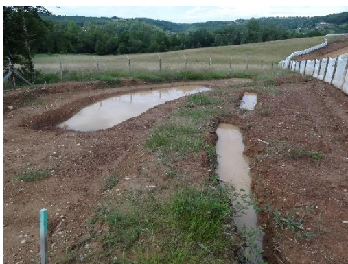
Exemple d'ornières et mare compensatoires réalisées aux abords de la déviation routière
