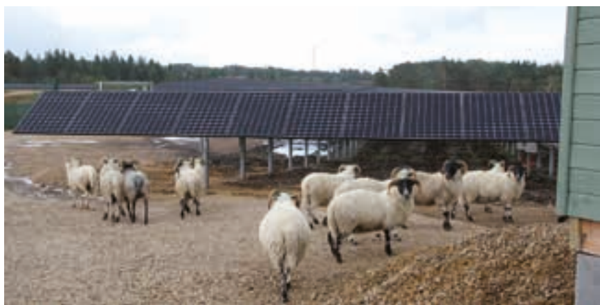
Centrale photovoltaïque de Gros-Chastang.
