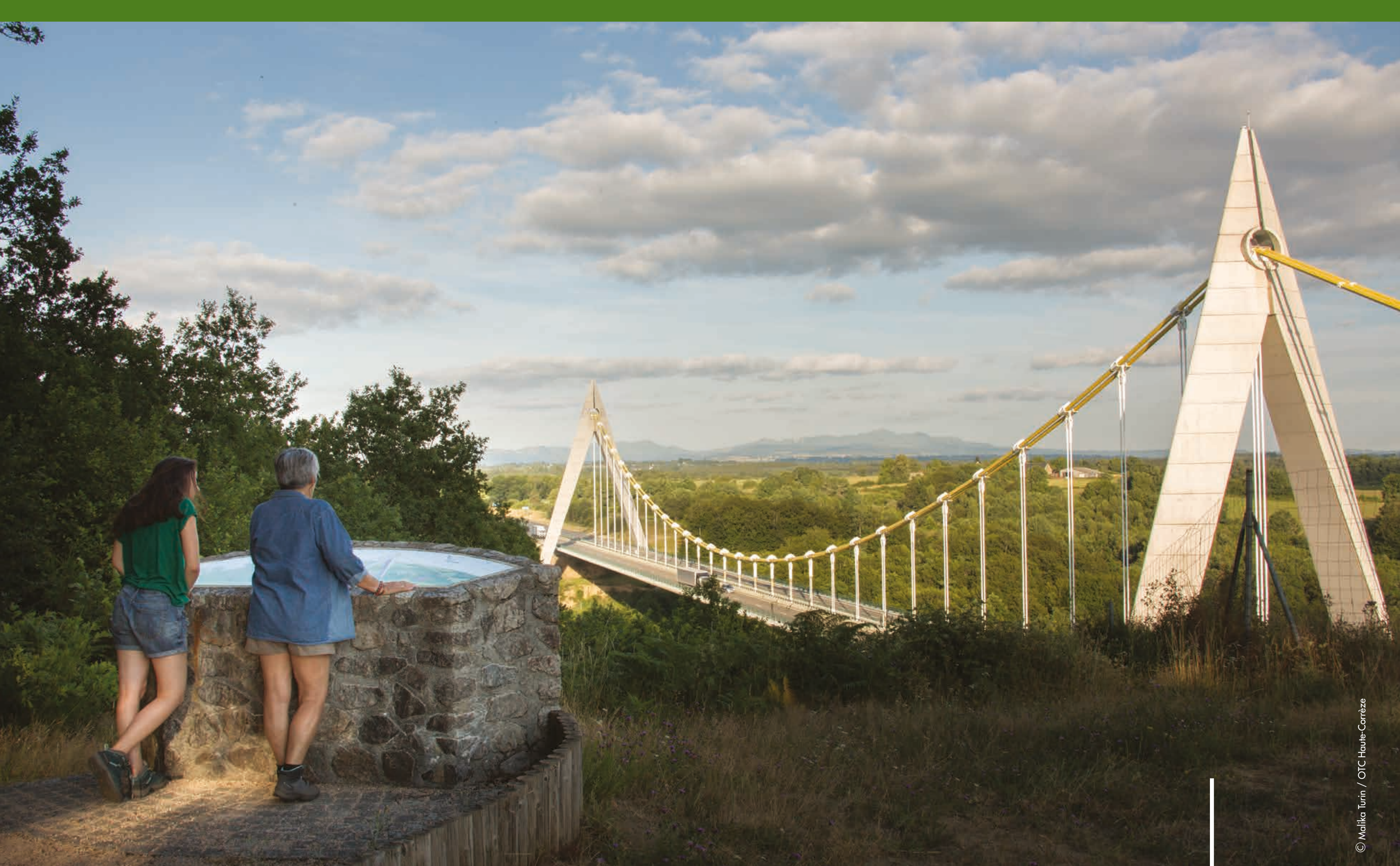
Viaduc du Chavanon
