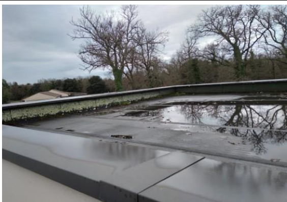
Toiture terrasse bâtiment Chaucre
