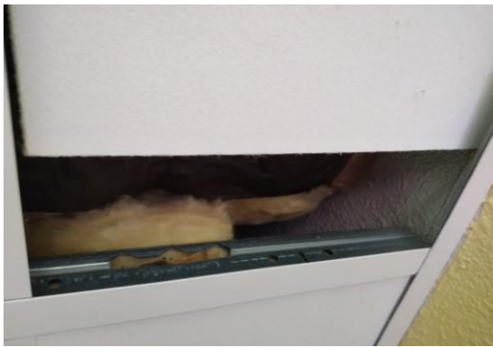
Isolation toiture salle d'activité
