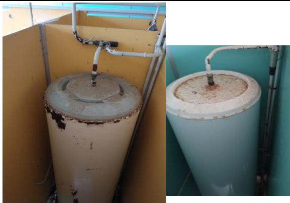
Ballons ECS ( à l'extérieur ) utilisés annexe salle activités
