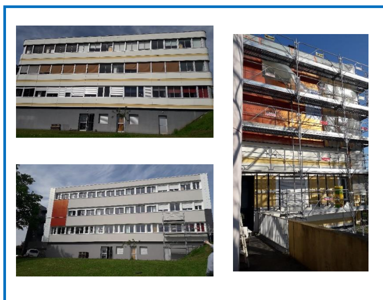
Isolation thermique et rénovation des menuiseries du collège d'Allasac
