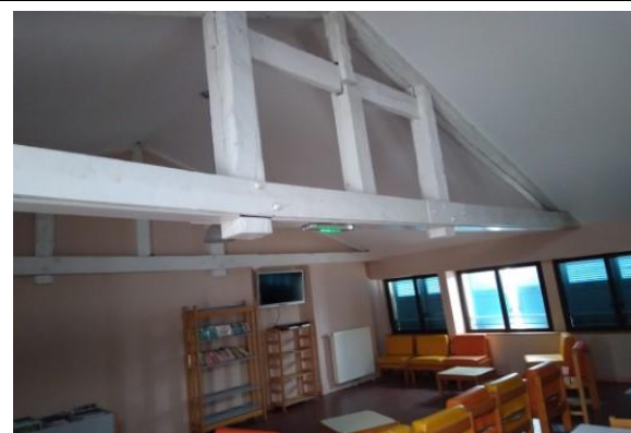
Combles bâtiment Chaucre
