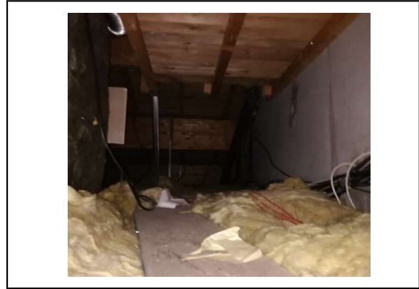
Toiture chalet de Charmoz
