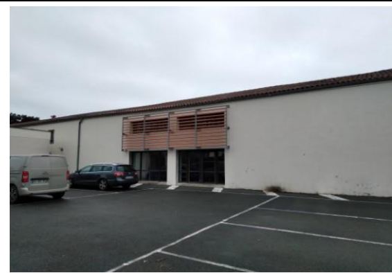
Facade bâtiment Chaucre
