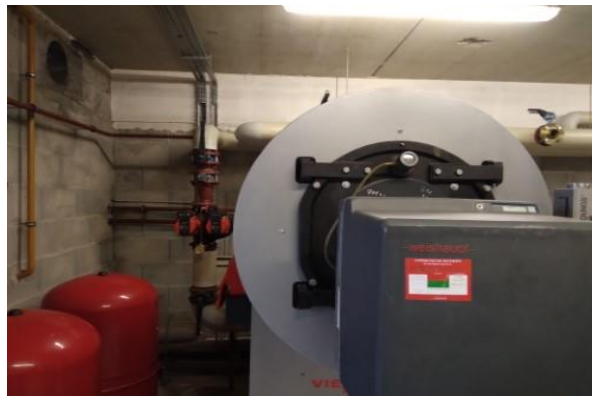
Chaudière propane à condensation
